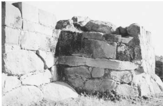
Figura 2b.- Bastión que oculta la fuente. Muralla norte.
