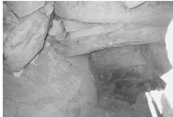
Figura 2a.- Fuente de Hijojejo. Cubierta.
